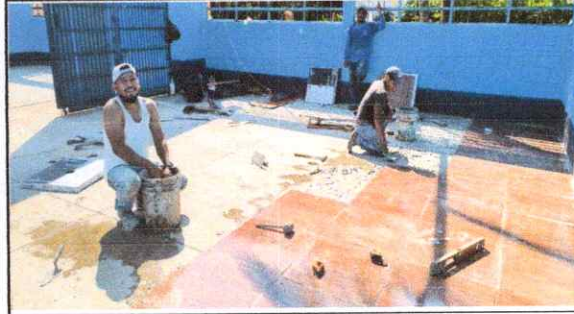
FOTO 4: Sustrucción de piso de cemento liquido por piso ceramico (modulo de aula I)
