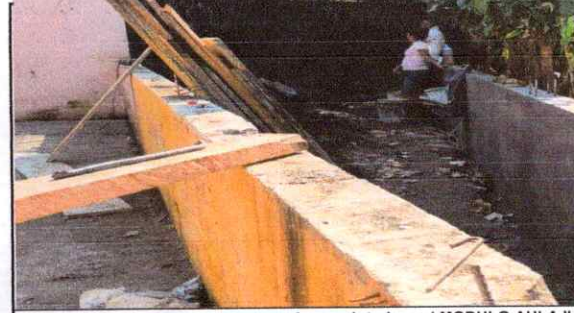
FOTO 6: Reparación en muros exteriores e interiores (MODULO AULA II)
