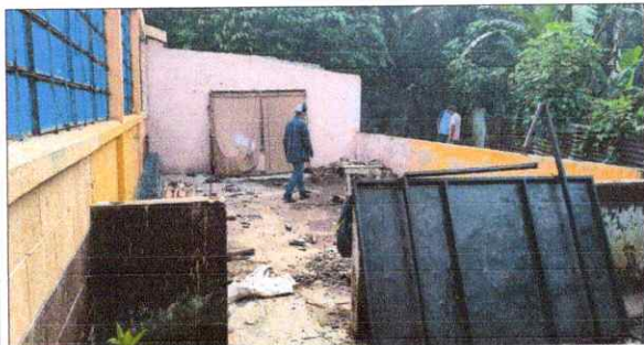
FOTO 5: Sustrucción de lámina, por lámina troquelada aluzinc calibre 26 y estructura portante (MODULO AULA II)
