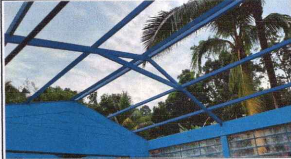
FOTO 2: Sustrucción de estructura de soporte de hierro de metal, por metal(modulo aula I)
