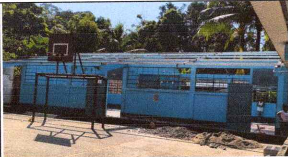
FOTO 1: Sustrucción de lámina, por lámina troquelada aluzinc calibre 26 (modulo aula I)
